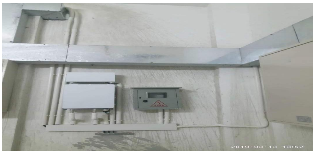
附图 12：室分信源挂墙安装示意图
