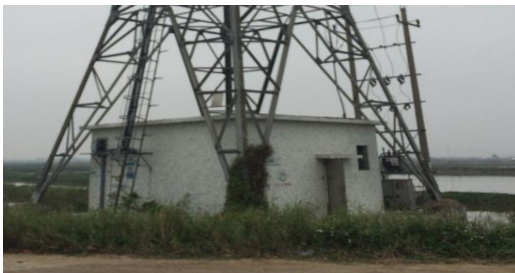
附图 13：地面标准土建移动通信机房外观示意图
