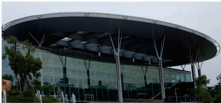
中国人民保险集团-南方数据灾备中心
