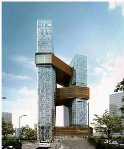
腾讯滨海数据中心
