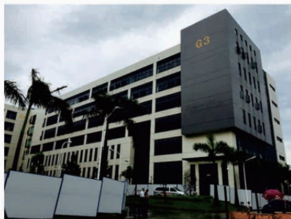
广州维腾数据中心
