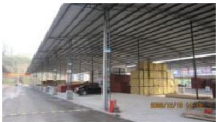
单层钢结构工程
