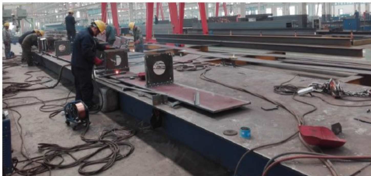
钢结构拼装平台
