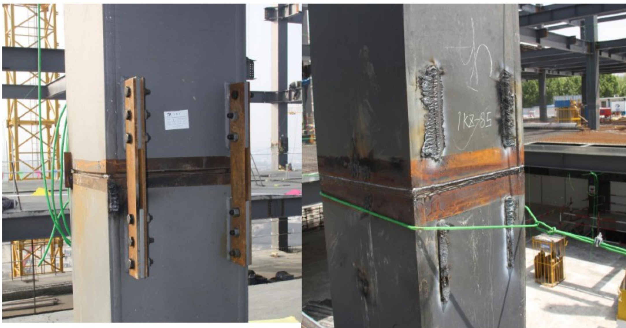
钢柱对接耳板
