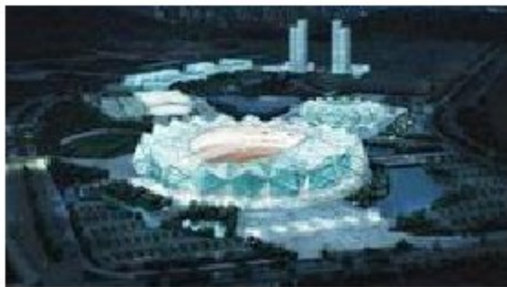
空间钢结构工程
