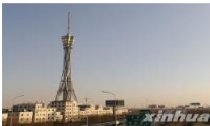
高耸钢结构工程
