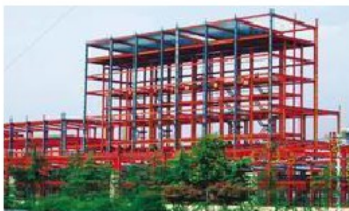
多层钢结构工程
