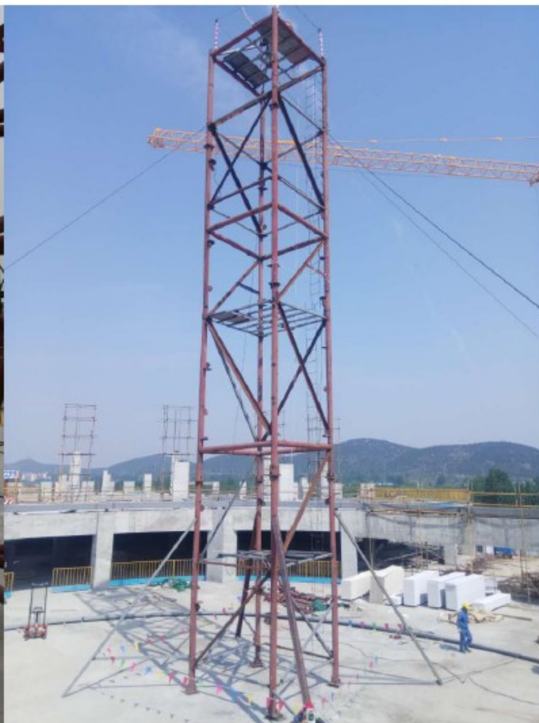
临时支撑塔架
