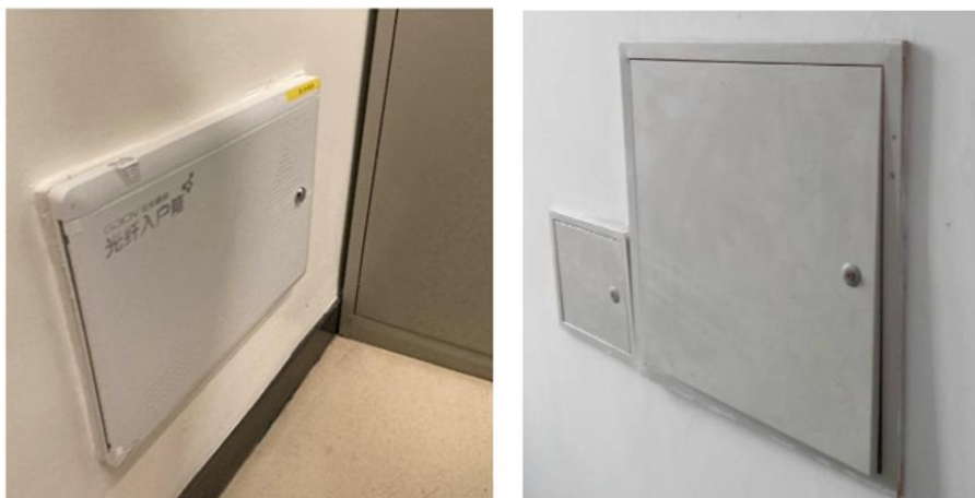
图 2-9：ONU 放置于信息箱内的安装方式
