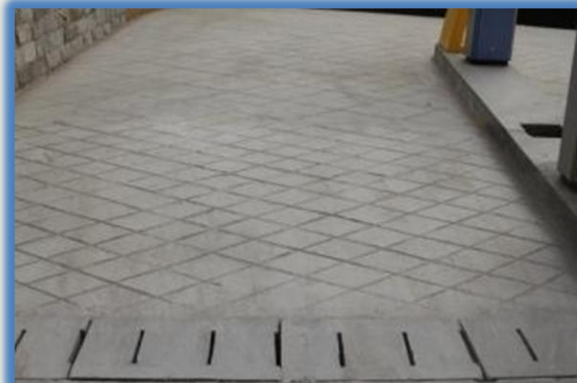
汽车坡道网状压纹
