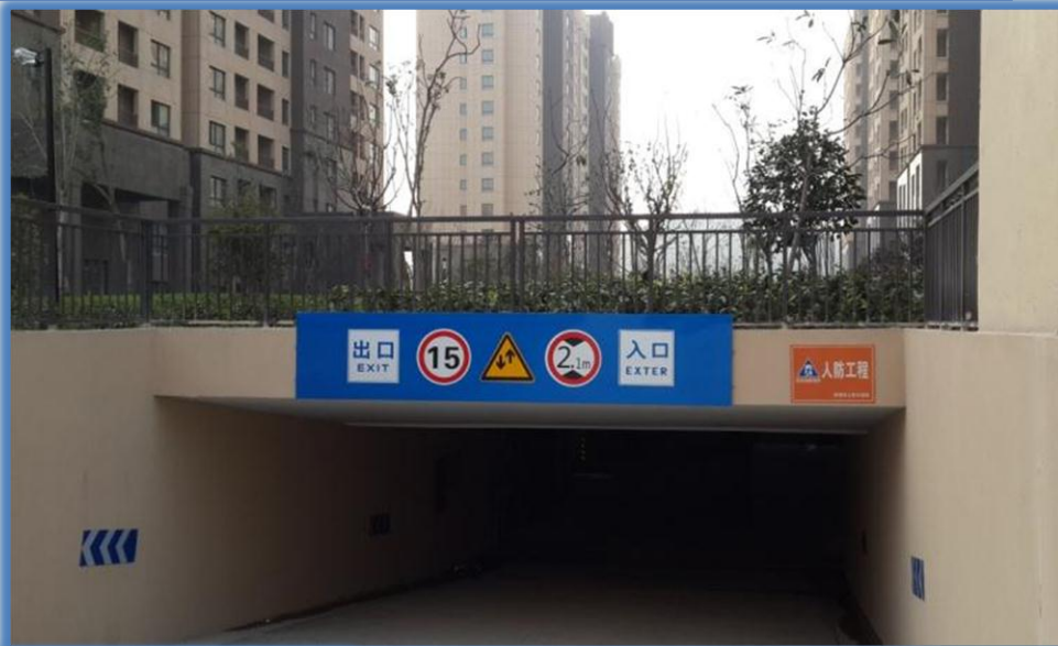
汽车坡道 入口标识
