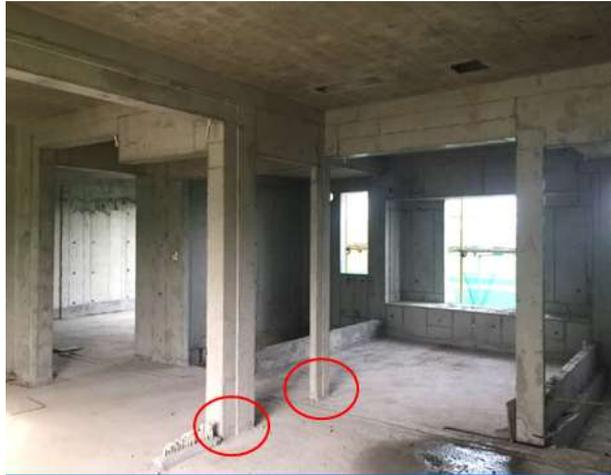
构造柱根部垫10mm泡沫板
