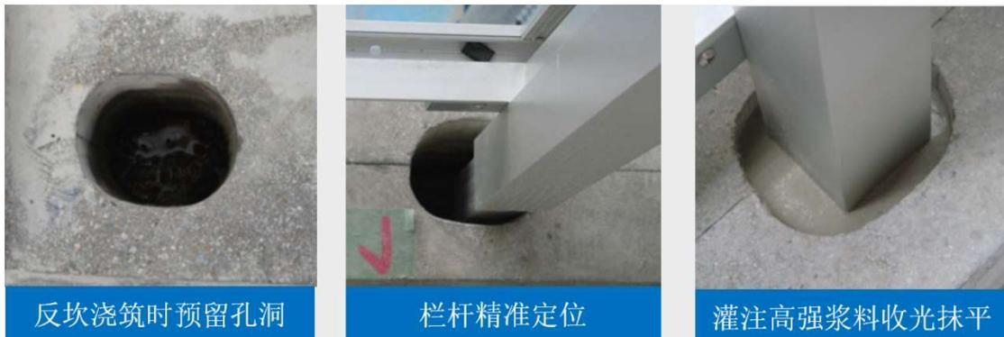
反坎浇筑时预留孔洞
