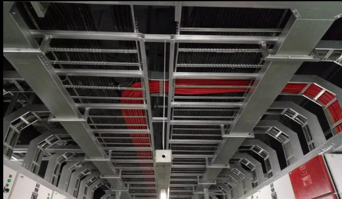
35万延长米矿物电缆采用原位煨弯装置转弧加工安装
