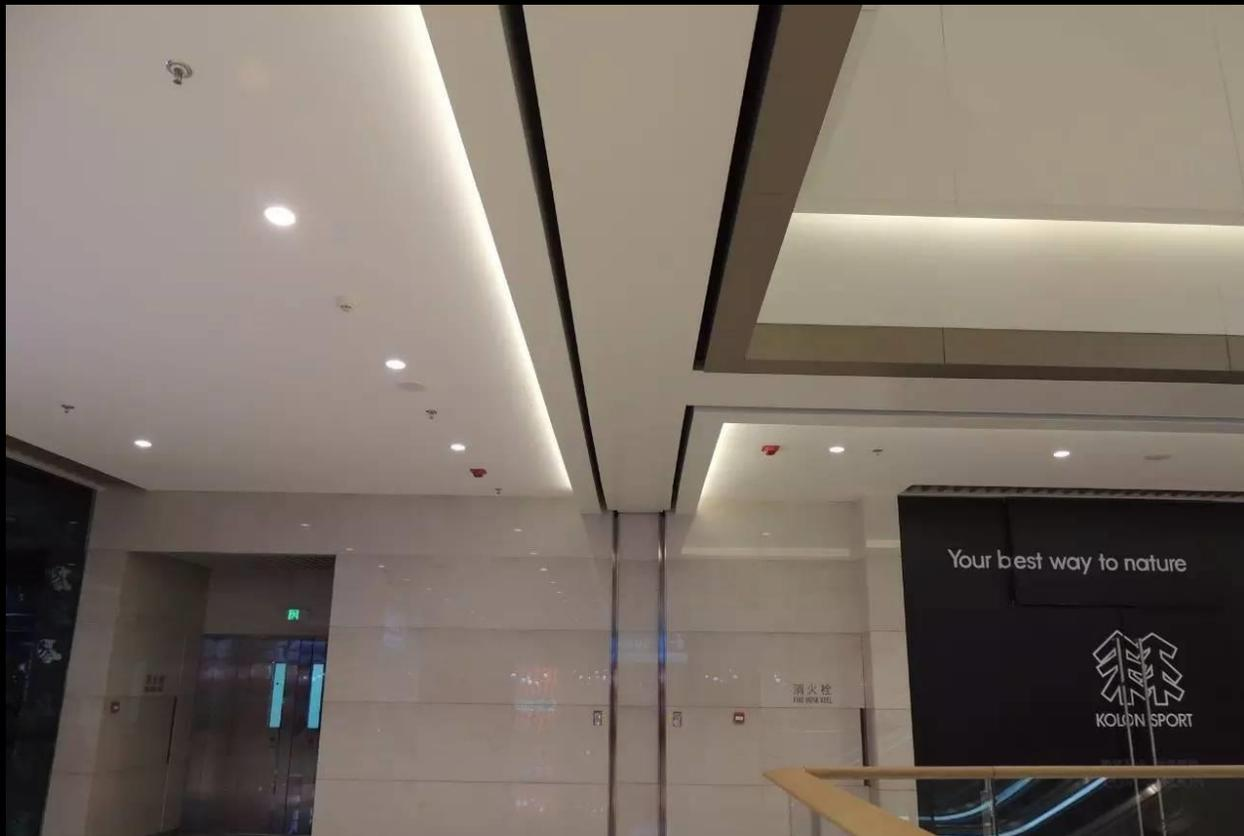
防火卷帘左右留缝一致，线性统一，底托面平整。
