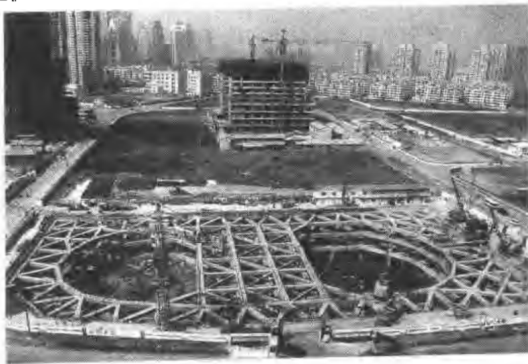
图 3-11 大空间的曲线形刚架支撑
