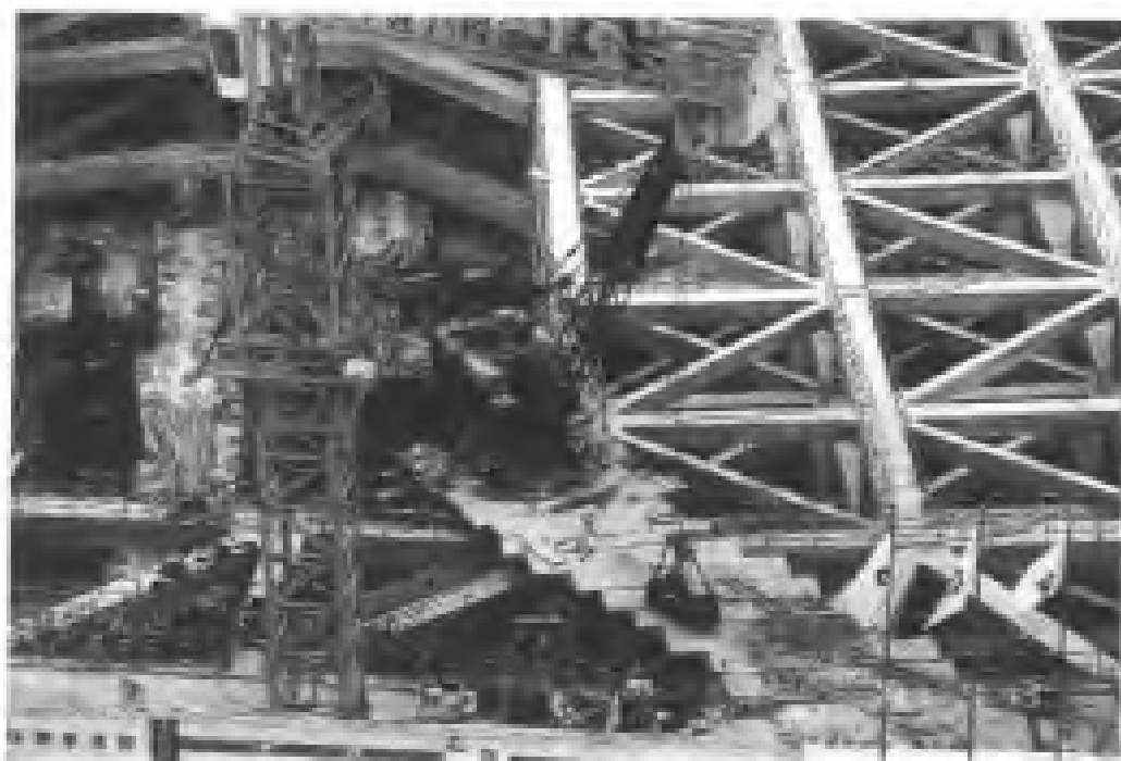
图 3-18 银冠大厦施工塔吊在基坑边履带吊在支撑上行走
