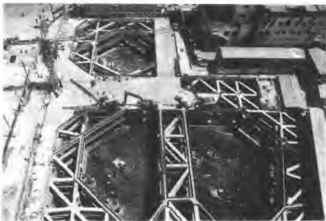
图 3-16 华美达广场支撑上的栈桥结构（塔吊设在基坑边上）
