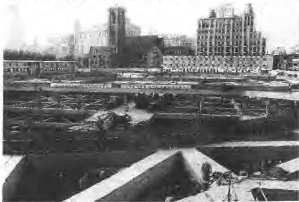
图 3-17 第二道支撑上的车行栈桥
