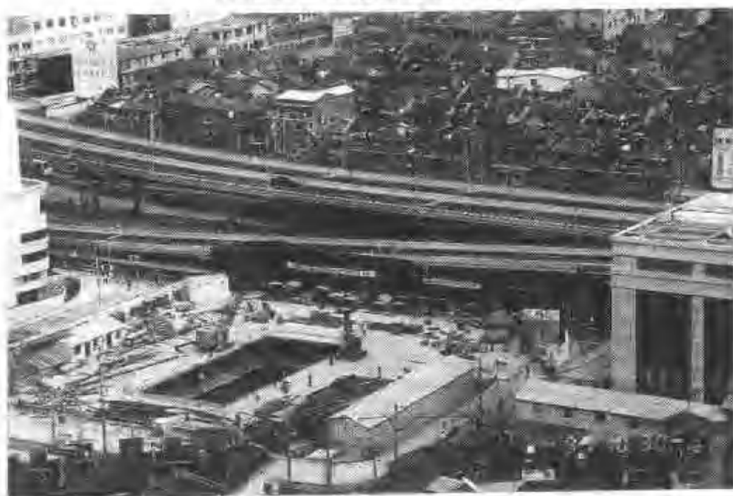
图 3-15 利用周边结构作支撑和栈桥的实例
