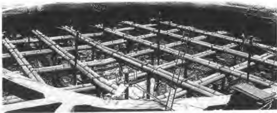
图 3-10 混凝土曲线形刚架支撑
