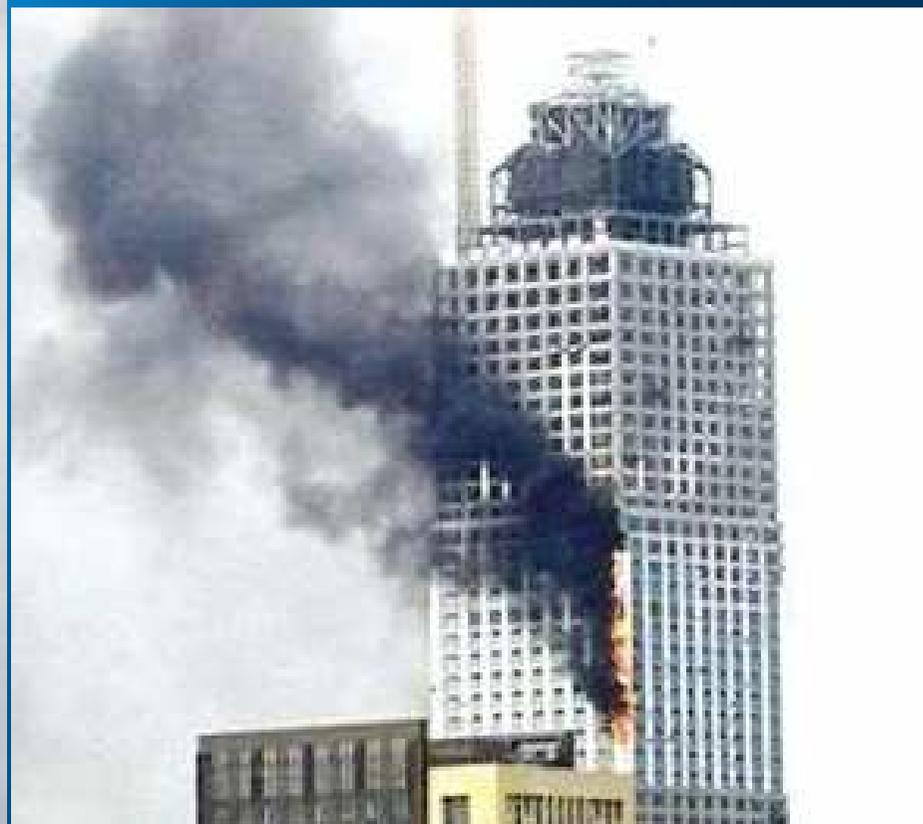
**中南汇泉国际广场**：2010年6月30日15时，在南通有“第一高楼”之称的超高层建筑，在进行外部装修时，大楼西南角幕墙的保温层由于电焊引起火灾，从33层分别蔓延至40层和14层。
