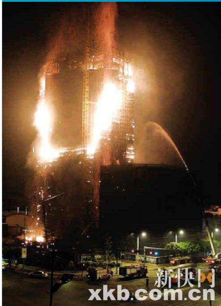
**岭南大厦：**2009年1月17日1时，即将封顶的岭南大厦发生火灾。现场起火原因初步判断为切割火花引起易燃品着火所致，无人员伤亡，但大楼只剩骨架
